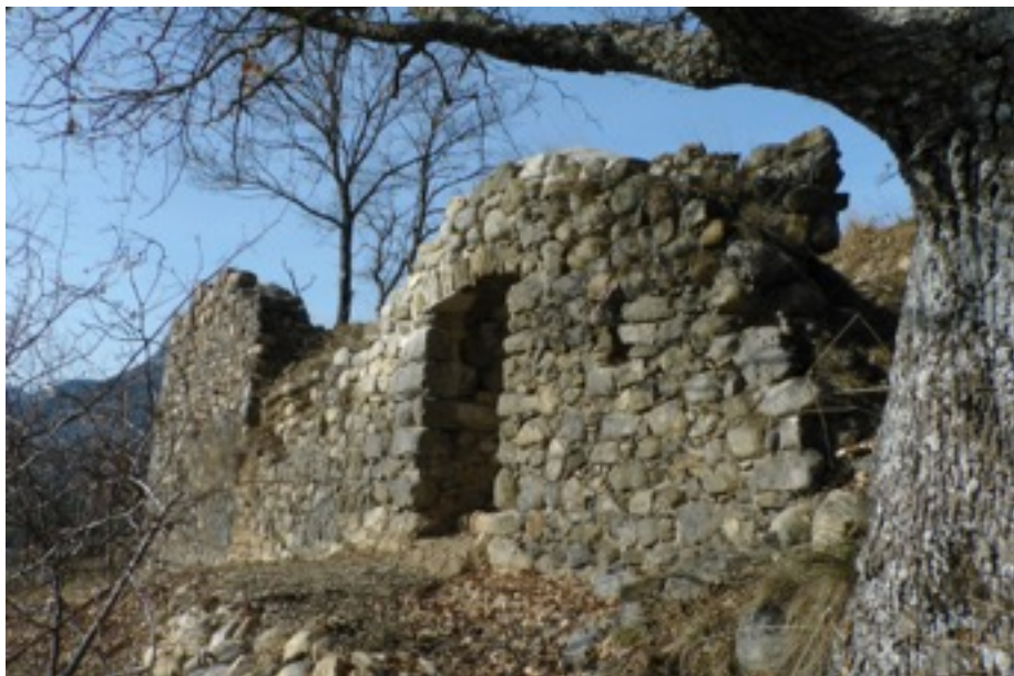
Avant les travaux et le débroussaillage
